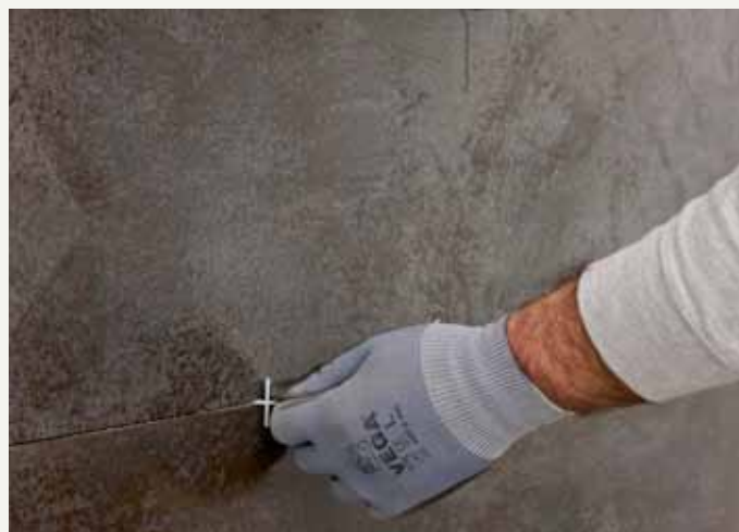
fig.37 / Fuga con distanziatori. / Application with spacers.
