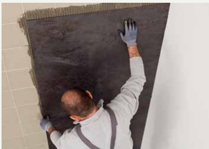
fig.38 / Posa della lastra. / Application of the slab.
