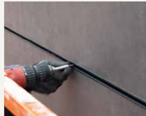
Fissaggio del pannello alla sottostruttura / Fixing the panel to the sub-structure
