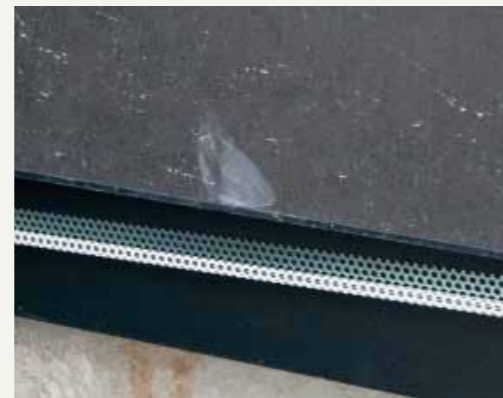
Installazione del profilo anti-intrusione / Installation of the anti-intrusion profile
